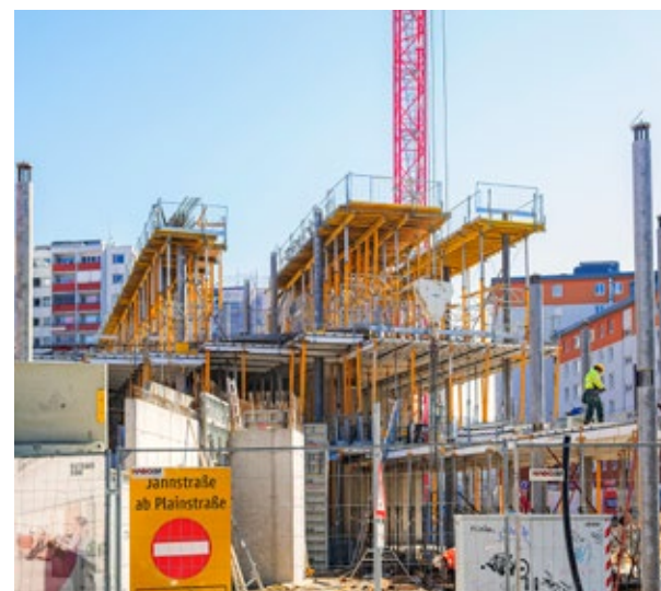
MULTIPROP: Leichte Deckenstütze aus Aluminium für besonders hohe Traglasten
