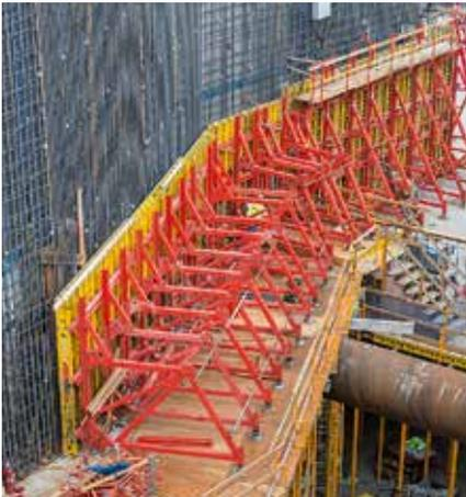
Bei niedrigeren Betonierhöhen von 4,00 m können die Stützbockrahmen SB-A und SB-C kombiniert werden.
