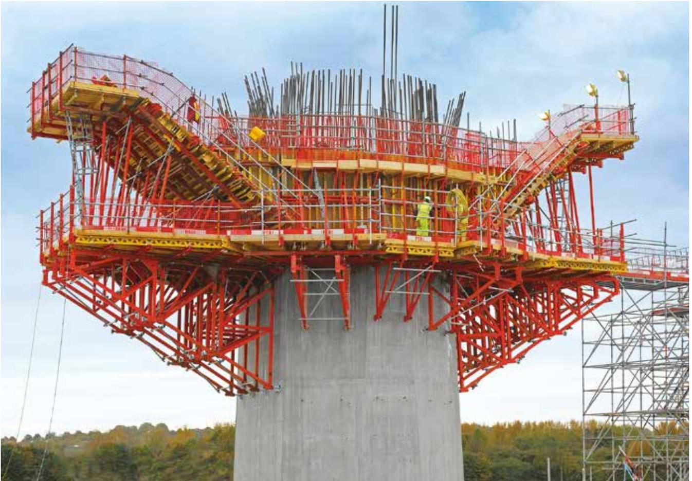
**Die Stützbocke können auch als horizontale Schwerlastkonsole eingesetzt werden. Diese Anwendung macht größere Arbeitsbühnen bis zu 8,75 m Breite bei gleichzeitiger Aufnahme von hohen Querkräften möglich.**
