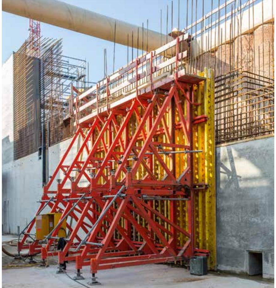
Die Schalungsaufnahme verbindet die Stützböcke SB-A0, A, B, C mit den Schalungssystemen MAXIMO, TRIO oder DOMINO.
