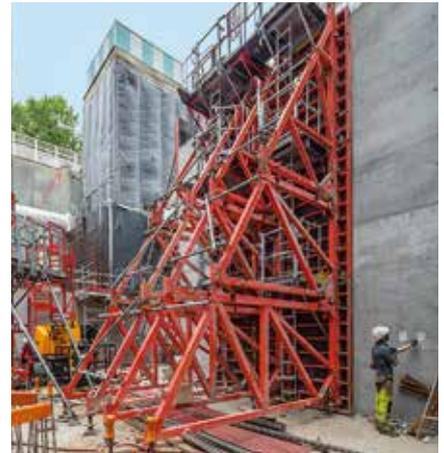
Durch eine entsprechende Montage von Gerüstrohren ist der Stützbock in der Einflussbreite an die Schalung anpassbar.
