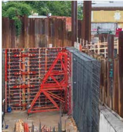
Beim einhäufigen Betonieren gegen bestehende Spundwände wird der gesamte Frischbetondruck über den Stützbock mit einer entsprechenden Verankerung in den Unterbau abgeleitet.
