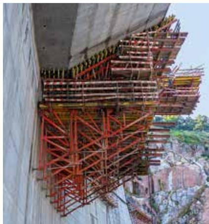
Die Stützbocke und Systembauteile des VARIOKIT Ingenieurbaukastens bilden großformatige Plattformen mit bis zu 8,75 m Breite.
