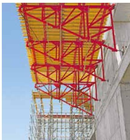
Die koppelbaren Stützbocke können horizontal als tragfähige Konsolkonstruktion eingesetzt werden.
