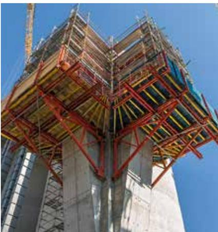
Das horizontal montierte Stützbocksystem bildet kombiniert mit Systembauteilen des VARIOKIT Ingenieurbaukastens weit auskragende Arbeitsbühnen.
