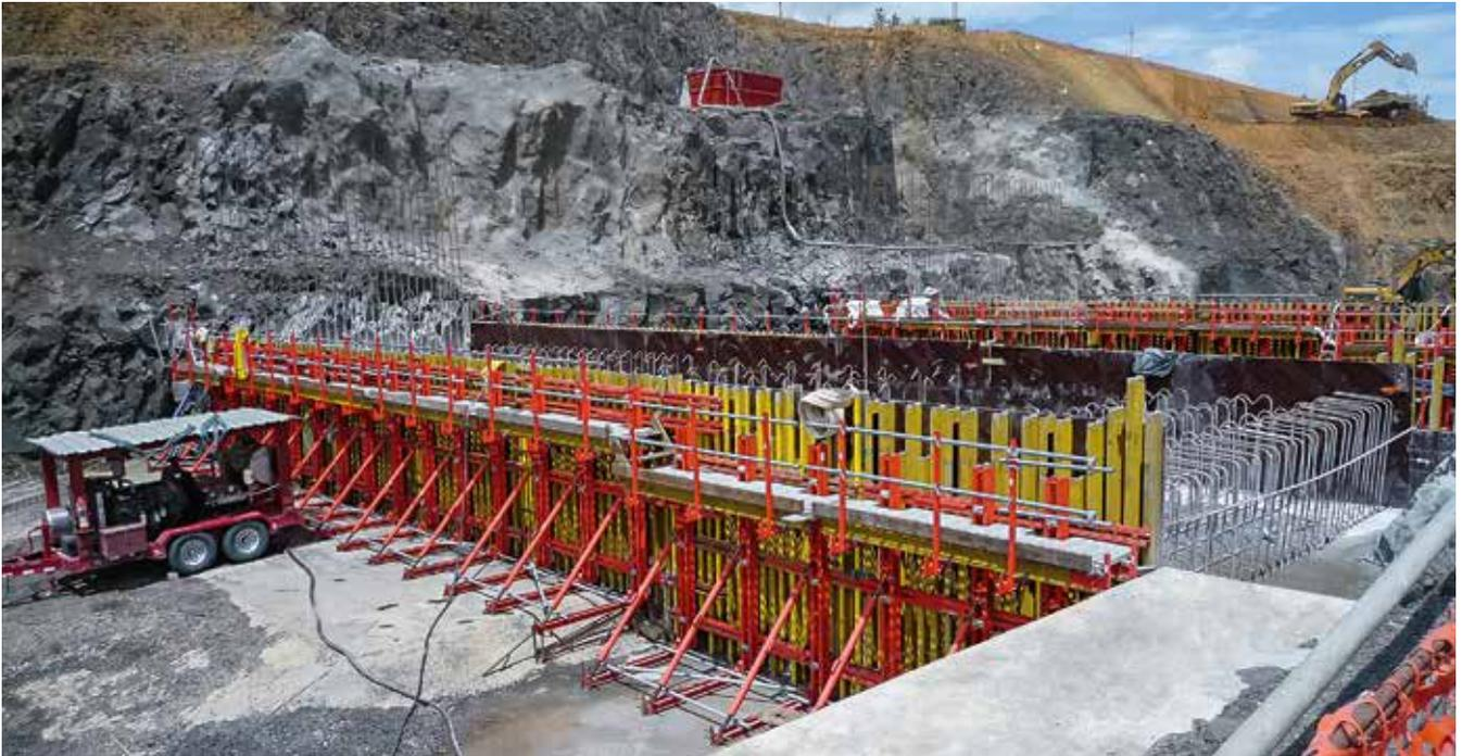
Der Stützbock SCS ist eine modulare Konstruktion aus Kippträger, Schwerlastspindel und Anfängerriegel. Für den ersten Betonierabschnitt des SCS Klettersystems wird ein Anfängerstützbock eingesetzt, diagonale Verankerungen leiten die Lasten in die Bodenplatte.
