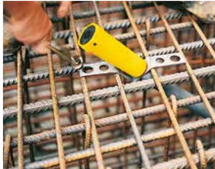
Mit dem V-Ankerhalter, als verlorenes Teil, ist eine exakte Ausrichtung des Zugankers auf 45° möglich.
