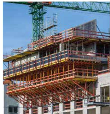
Horizontal eingesetzte Stützbocke können bei Deckenauskragungen hohe Traggerüste ersetzen.
