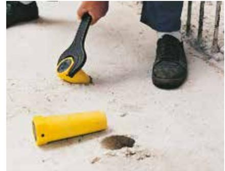
Die Vorlaufkupplung kann nach dem Betonieren wiedergewonnen werden.
