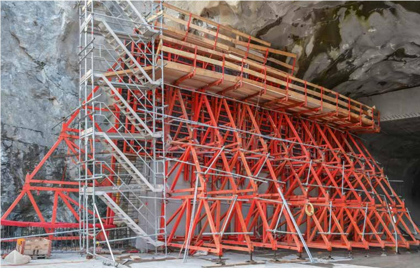
An jeder Stelle des Stützbocks SB-A0, A, B, C ist die Kräfteinleitung gewährleistet.
