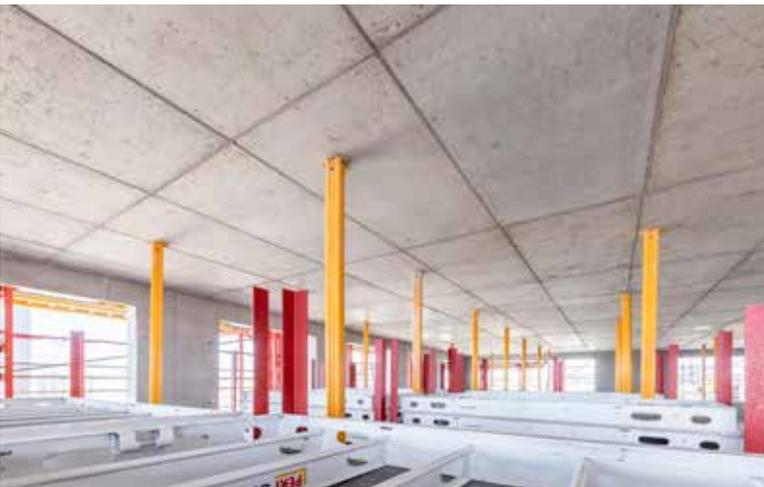
Das geringe Eigengewicht der SKYMAX Paneele von gerade einmal 32 kg beschleunigte das Einschalen erheblich und sorgte für ermüdungsfreieres Arbeiten. Der Absenkkopf ermöglichte zudem ein zeitnahes Ausschalen, was zu einer geringen Vorhaltemenge führte. Dies kam wiederum den beengten Platzverhältnissen auf der Baustelle zugute.
