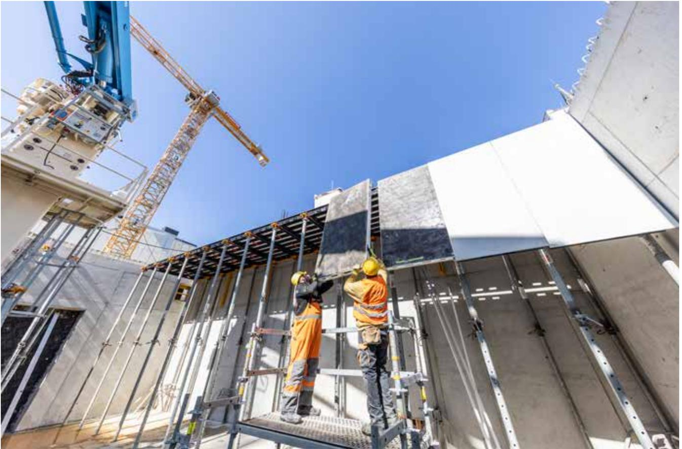
Selbst hohe Decken über 3,80 m können Sie mit PERI Systembauteilen von der unteren Ebene aus schalen. Die Kompatibilität der Bauteile aus Aluminium und Polymer bietet Ihnen eine optimale Anpassung an Ihre Baustellenbedürfnisse.
