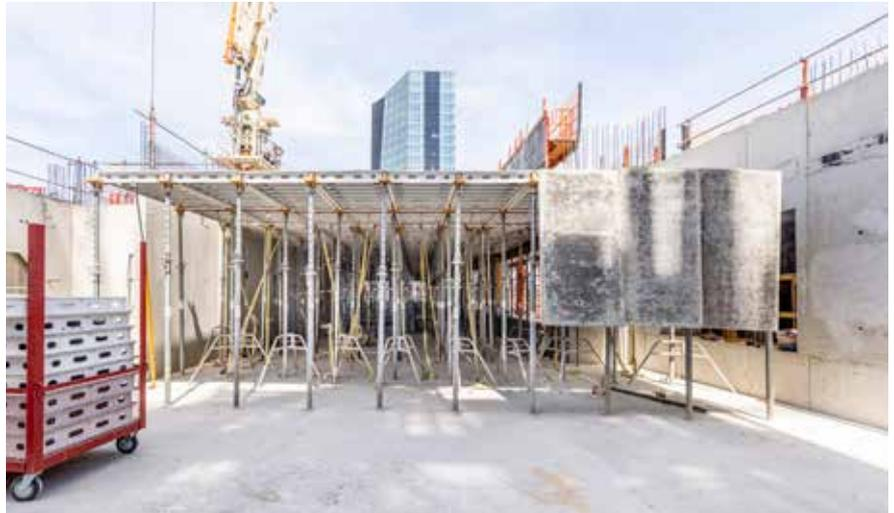
Die durchdachten SKYMAX Systembauteile im Baukastenprinzip steigern die Produktivität und Sicherheit auf Ihrer Baustelle.
