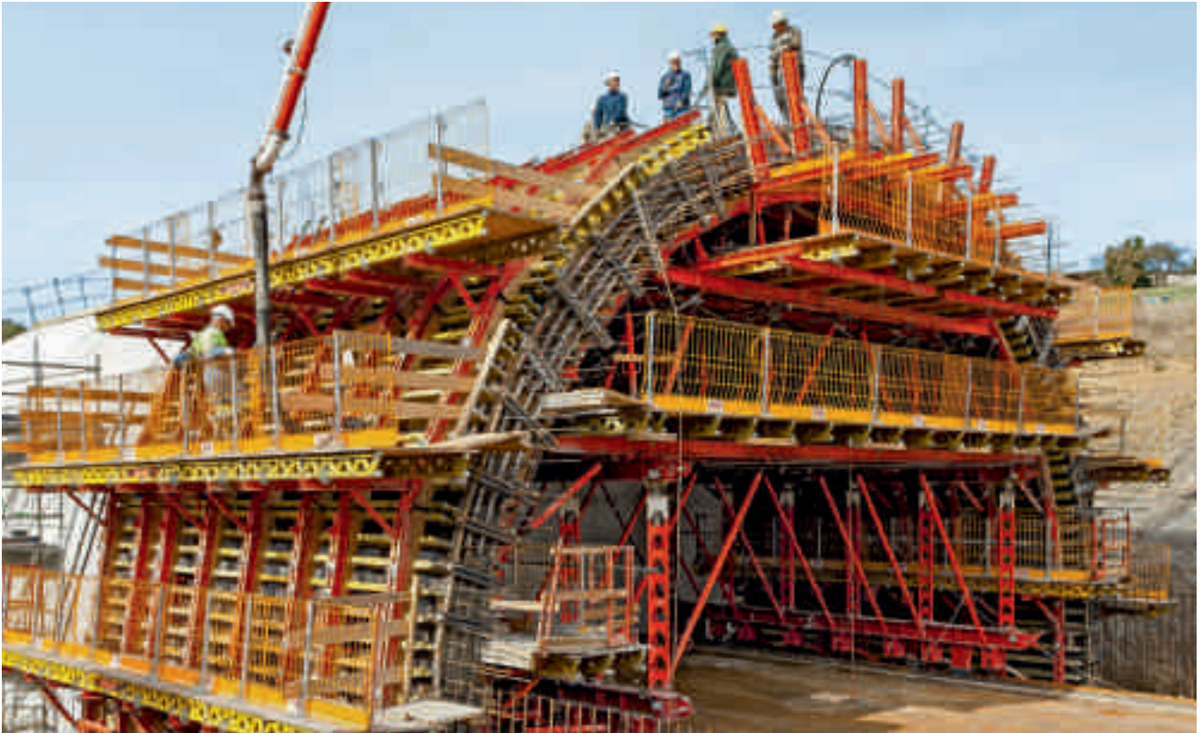
PROKIT EP 110 bietet Schutz an den freien Rändern der Arbeitsplattformen dieser Tunnelschalung.
