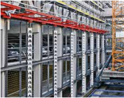
HD 200 Schwerlaststützen als platzsparende Lösung: 8 m hohe Stützen tragen die Lasten eines Arbeits- und Schutzgerüsts auf beengtem Raum ab.
