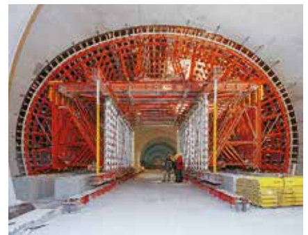
Das verfahrbare Längsfachwerk für diesen Tunnel aus dem HD 200 Schwerlastsystem wurde als Portal ausgebildet. So war der ungestörte Bau-stellenverkehr längs der Trasse jederzeit möglich.
