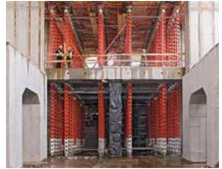
Hohe Lasten mit geringem Platzbedarf abtragen – bei diesem Kraftwerksbau lassen sich die Vorteile der HD 200 Schwerlaststütze bestens nutzen.
