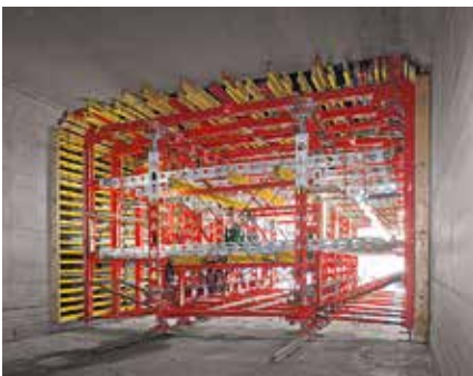
HD 200 Stützen als Aussteifung: Die Schwerlaststützen gleichen die Horizontal-lasten aus dem Betondruck aus; das vermeidet aufwändige Ankerlösungen.
