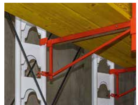
Mit der Konsole lässt sich eine 75 cm breite Arbeitsbühne erstellen.
