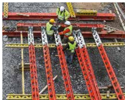
Die Jochscheibe wird in der Regel liegend aufgebaut – komplett mit Diagonalverbänden, Arbeitsbühne und Leiteraufstieg.
