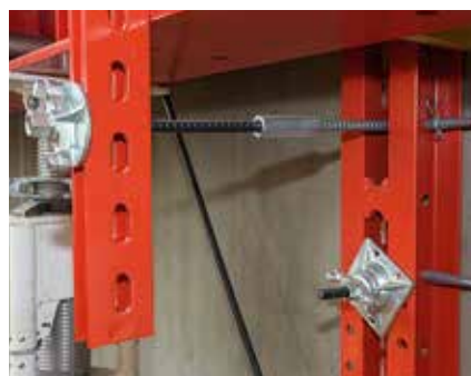
Horizontallasten rechtwinklig zur Jochebene können direkt vom Jochträger HDT in bestehende Bauteile, z. B. Widerlager, eingeleitet werden.
