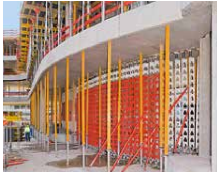
Eine leichte und tragfähige Lösung: Unterhalb von Wandscheiben tragen HD 200 Schwerlaststützen Linienlasten von bis zu 400 kN/m bis in die Bodenplatte ab.
