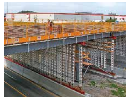
HD 200 Jochträgerscheiben beim Bau einer Straßenüberquerung in Stahlverbundbauweise.
