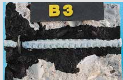
... sowie bei einbetonierten Ankerstäben.
