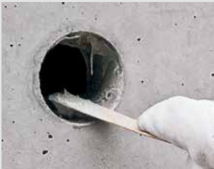
Die gereinigte Abdruckstelle mit dem Dichtungskleber dünn einstreichen.
