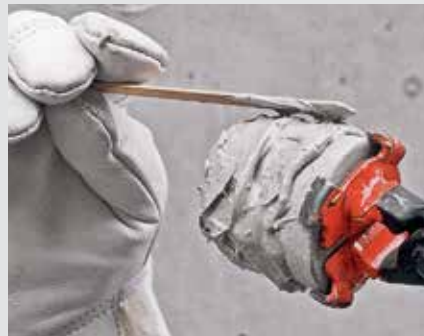
Den Betonkonus mit der Konuszange halten und sowohl die Seiten- als auch die Stirnfläche gleichmäßig mit Kleber bestreichen.
