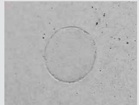
Eine saubere und dichte Ankerstelle mit dem PERI Ankersystem.
