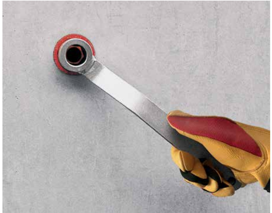
Ausbau der DK Dichtungskonen mit dem DK Konusschlüssel UNI.
