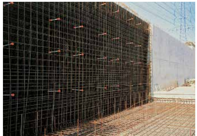
Tunnel in Häggsviksleden, Schweden.
