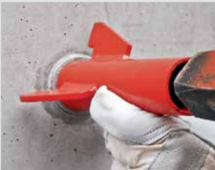
Den Betonkonus mit der Richtlehre plan klopfen.
