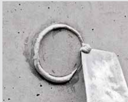
Den überschüssigen Dichtungskleber mit der Spachtel abstreifen.
