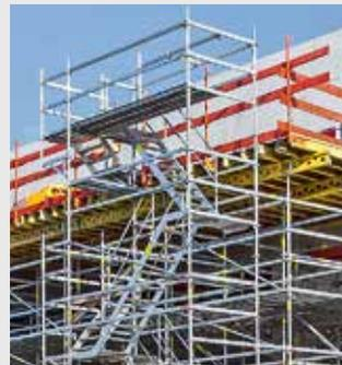
Höhenanpassungen an Gebäudeöffnungen erfolgen unabhängig von den Etagenhöhen mit seitlich angebauten Konsolen und kurzen Treppenläufen mit 1,50 m Länge sowie 50 cm bzw. 100 cm Höhe.
