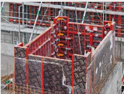
Beim Lösen der Schachtecken und Ziehen mit dem Kran entsteht ein Ausschalspiel von 35 mm an jeder Seite.
