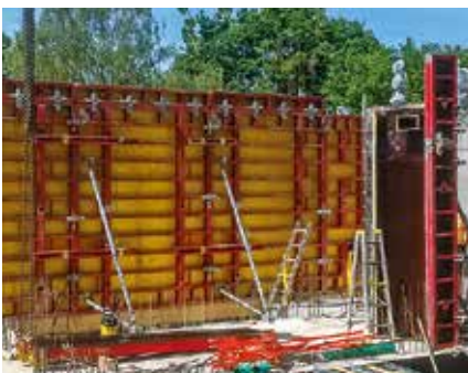
Die MAXIMO Struktur ist eine Variante der bewährten MAXIMO Rahmenschalung, sie ist mit dem gesamten MAXIMO Zubehör verwendbar.
