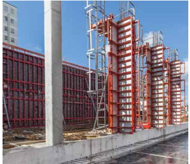
Die Wände des Stadtquartiers am Hirschgarten wurden mit der MAXIMO Rahmenschalung in kürzester Bauzeit geschalt.
