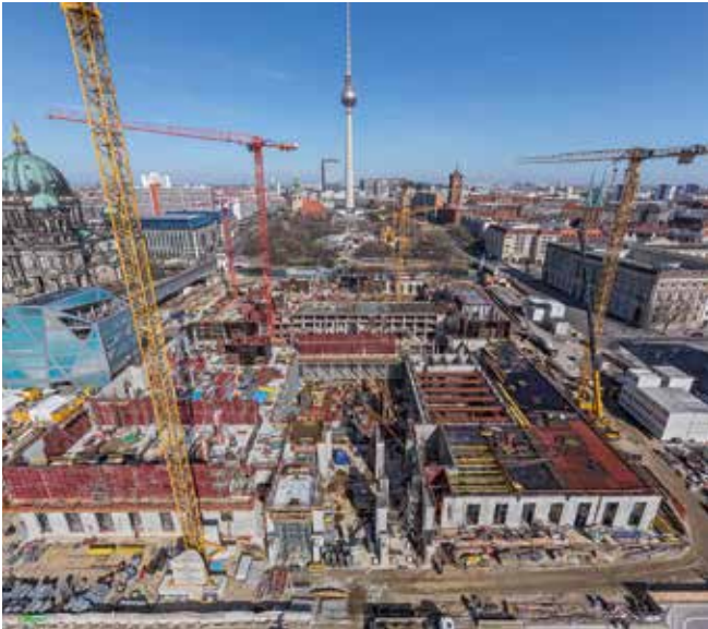
Über 6.000 m 2 MAXIMO Rahmenschalung waren beim Bau des Stadtschlusses in Berlin zeitgleich im Einsatz.
