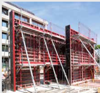
Die Arbeitsbühnen werden am Element der entsprechenden Breite montiert und verbleiben auch bei der Zwischenlagerung an der Schalung.
