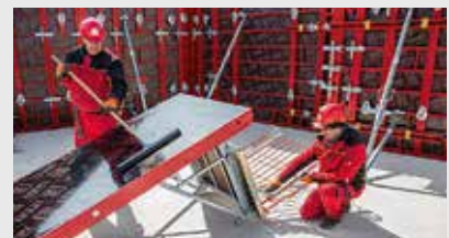
Die Arbeitsbühnen werden am Element der entsprechenden Breite montiert und verbleiben auch bei der Zwischenlagerung an der Schalung.
