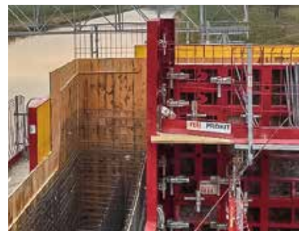
MAXIMO Struktur ist mit den MAXIMO Standardelementen kombinierbar. Dies ist von Vorteil, da spezielle Oberflächen häufig nur an einer Seite gefordert sind.
