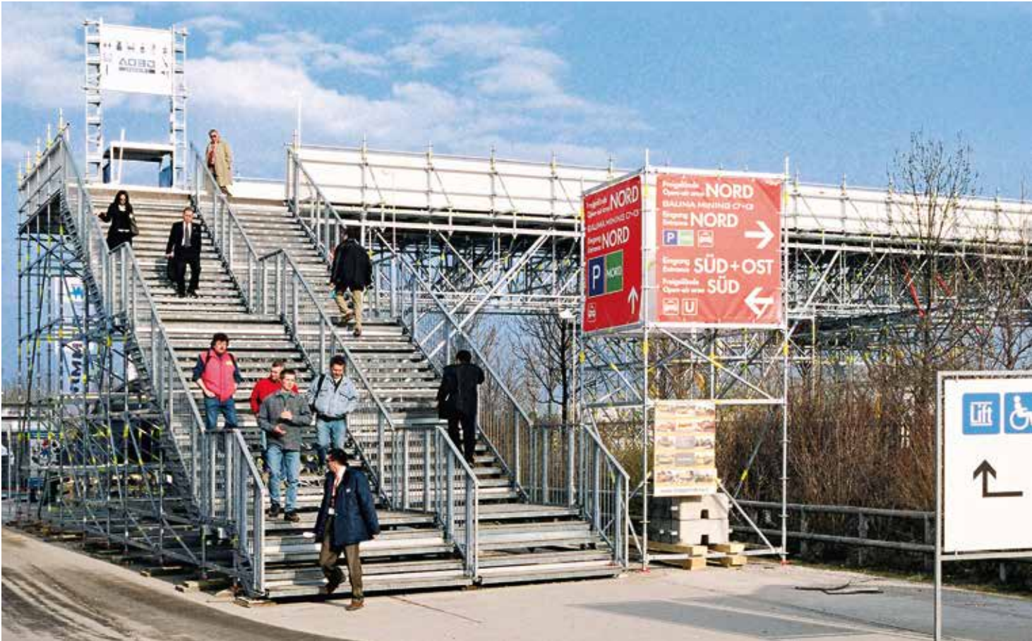
Lösung für eine Messe: Treppe zu einer Fußgängerbrücke über eine mehrspurige Straße mit getrennten Bereichen für den Auf- und Abgang.
