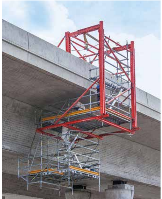
Durch baustellengerechte Systemkombinationen des VARIOKIT Ingenieurbaukastens mit PERI UP Flex sind flexible und projektspezifisch optimierte Baustellenlösungen möglich.
