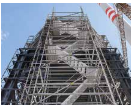
Gegenläufige Gerüsttreppen bieten eine große Kopffreiheit und kurze Laufwege bei hohen Aufstiegen.
