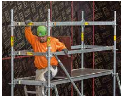
Der Durchstiegsbelag erleichtert das Wechseln der Arbeitsebene für den Gerüstnutzer.
