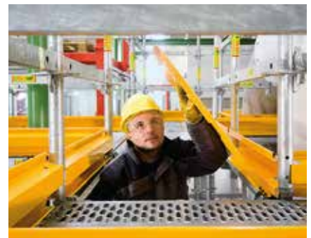
Klappen in gelber Signalfarbe lassen sich zur Seite öffnen. Sie schließen selbsttätig – das vermeidet Gefahrenquellen.
