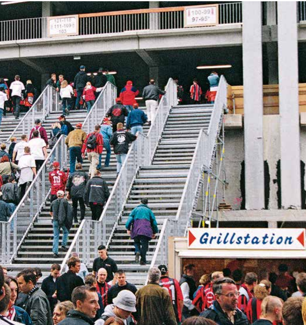
Treppenanlage im Zuge des Umbaues eines Fußballstadions. Sie wurde für die Fußballspiele am Wochenende benötigt und für die Bauarbeiten unter der Woche mit dem Kran an einen Lagerplatz versetzt.
