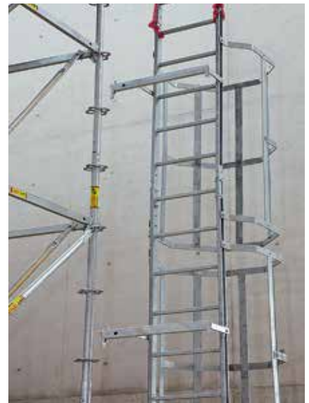
Einhängen mit Kran, danach Keile festschlagen.
