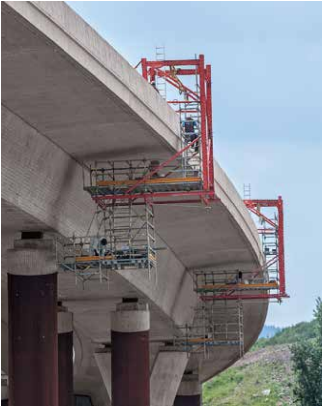
Zwei fahrbare PERI Hängegerüste sorgen für eine optimale Zugänglichkeit zur Brückenuntersicht einer Autobahnbrücke.
