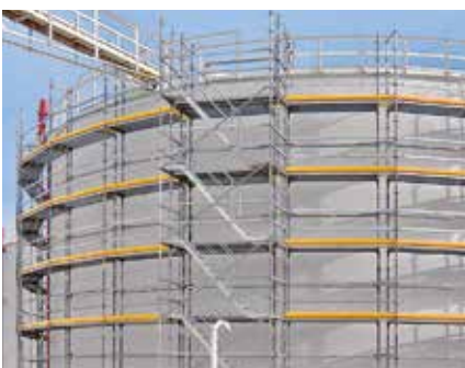
Gleichläufige Gerüsttreppen haben den Vorteil, dass neben den Treppenläufen auch Arbeits-ebenen verfügbar sind.
