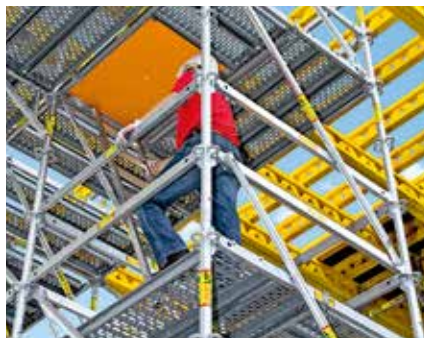
Als Zugang zu der oberen Arbeitsplattform bei Stütztürmen lassen sich Durchstiege mit separater Leiter auch in Feldern mit nur 1,50 m Feldlänge einsetzen.
