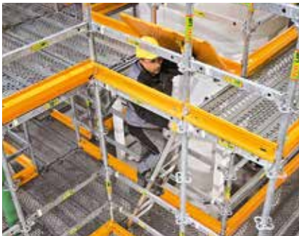
Die Durchstiege mit den Breiten von 50 cm und 75 cm können auch in Felder mit geringer Feldlänge eingebaut werden.
