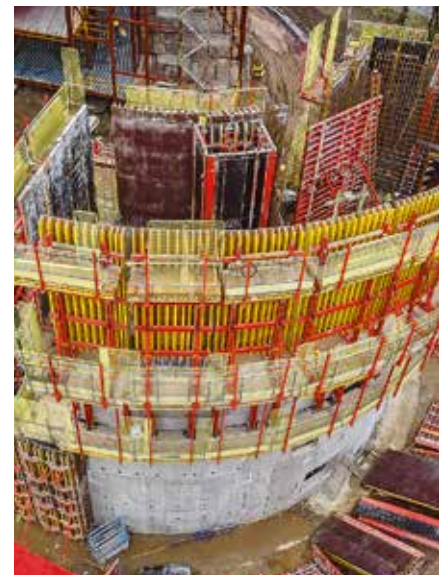
Ein Einsatz der leichten Schienenkletterschalung bei einem runden Bauwerk mit der VARIO GT 24 Träger-Wandschalung.
