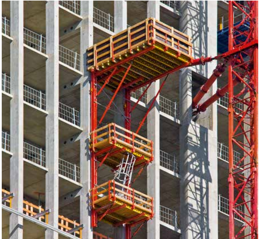
Diese selbstkletternde RCS Konsolbühne mit 2 Nachlaufbühnen an einem Hochhaus ist mit dem RCS Wandschuh an den Fassadenstützen verankert.
