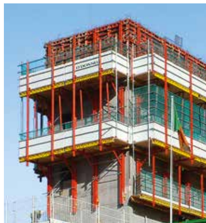
Mit dem RCS Schienenklettersystem kommen verschiedene Wandschalungssysteme zum Einsatz, so auch die bewährte TRIO Rahmenschalung.
