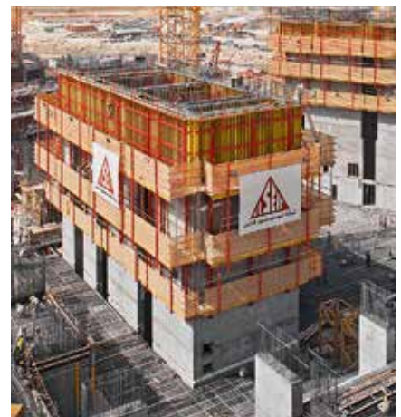
Sicheres Arbeiten mit durchgängigem Seiten- und Rückenschutz auf und unter der Kletterschalung RCS C.
