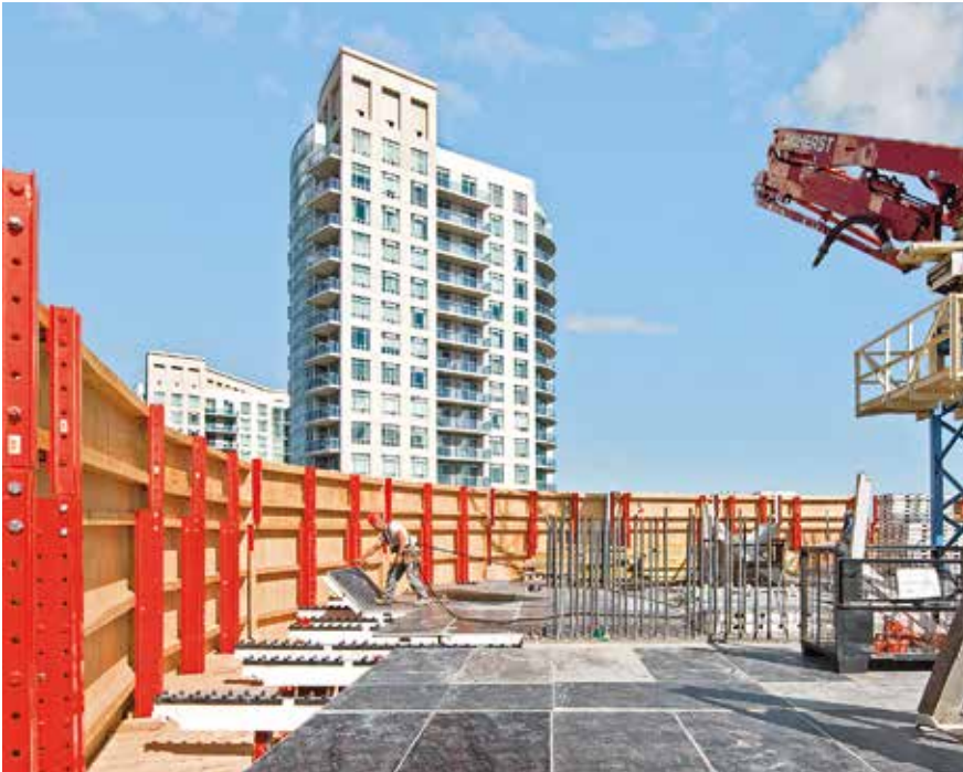
Der abgeschirmte Arbeitsraum bietet Schutz vor Wind und Wetter. Zudem bewirkt die Einhausung ein Gefühl von Sicherheit; das steigert die Arbeitsproduktivität erheblich.
