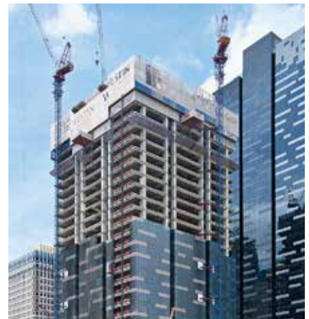
Die Kletterschutzwand RCS im Einsatz beim Bau des Asia Square Tower in Singapur. Die integrierten Ausfahrbühnen sorgen für einen einfachen Materialtransport von Geschoss zu Geschoss.
