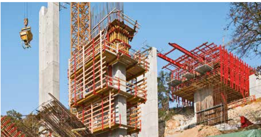
Ein weiterer, typischer Anwendungsbereich für das RCS Schienenklettersystem sind Brückenpfeiler.
