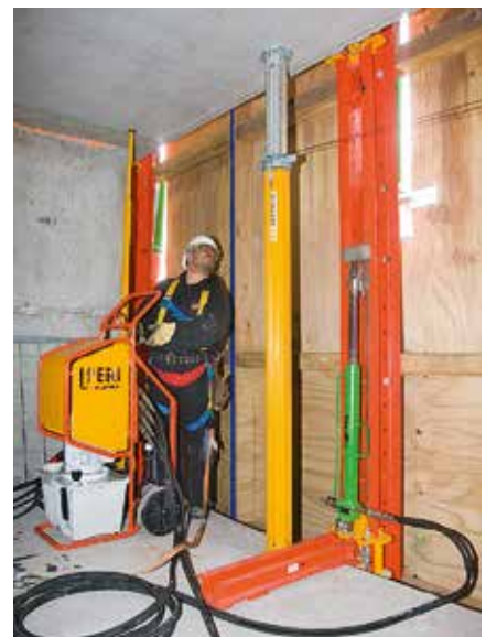
Die Klettereinheiten werden mit einer Hubgeschwindigkeit von 1 m/min. nach oben gehoben.
