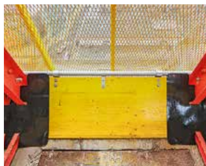
Der abgeschirmte Arbeitsraum bietet Schutz vor Wind und Wetter. Zudem bewirkt die Einhausung ein Gefühl von Sicherheit; das steigert die Arbeitsproduktivität erheblich.
