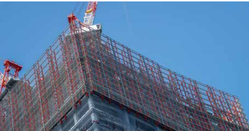
Diese lückenlose Gittereinhausung in Japan sorgt für hohe Sicherheit und gleichzeitig für Licht- und Luftdurchlässigkeit.
