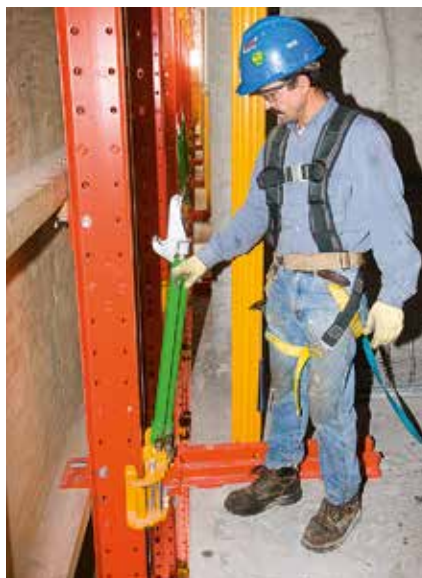
Die Hydraulikzylinder mit 5 t Hubkraft werden auf dem Kletterschuh positioniert.
