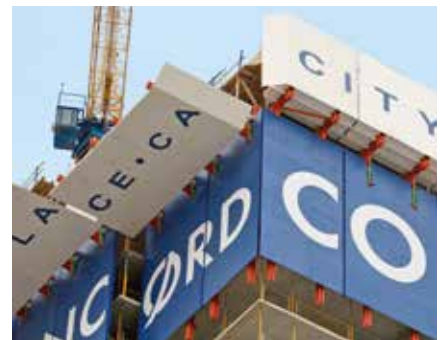
Bei Sonderlösungen mit hydraulisch abklappbaren Einheiten der Kletterschutzwand lassen sich großflächige Deckentische einfach ausfahren.
