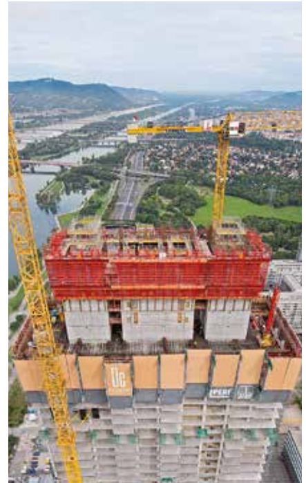
Die mehrfach geknickte Fassadenkonstruktion prägt den DC Tower in Wien. Die Kletterschutzwand passte sich den veränderlichen Geschossflächen stetig an.
