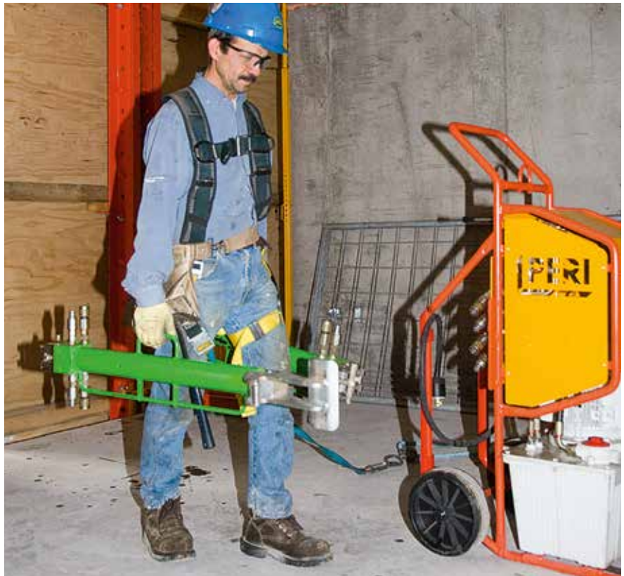
Die gewichtsoptimierten Komponenten der mobilen Kletterhydraulik sind leicht zu transportieren und äußerst einfach zu handhaben.
