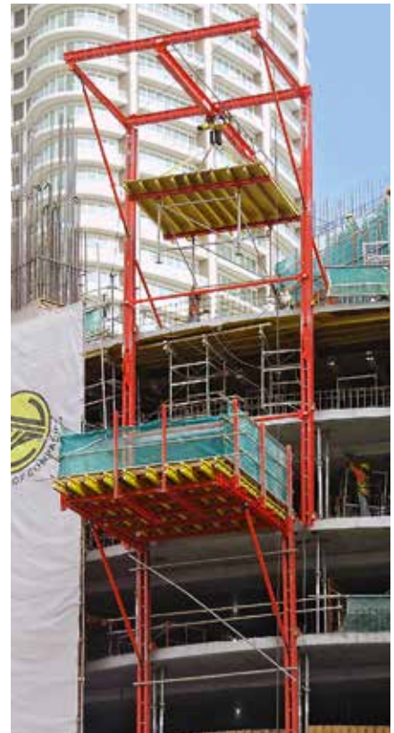
Hubkonsole und Ausfahrbühne Die oberste Absturzsicherung bleibt intakt – die Last wird einfach darüber hinweggehoben.
