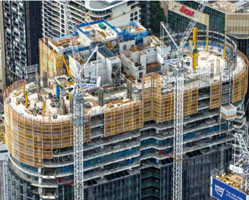
In Australien werden aufgrund der hohen Temperaturen häufig Gittereinhausungen eingesetzt. Sie lassen nicht nur Luft sondern auch Licht ins Bauwerk.
