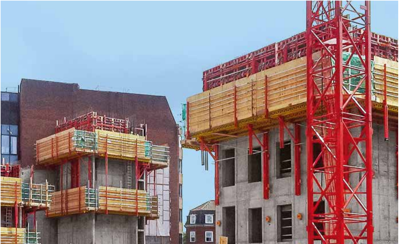
RCS CL klettert an diesen Bauwerkskernen kranunabhängig nach oben – teilweise sogar ohne Nachlaufbühne. Die Demontage der Zwischenkletterschuhe erfolgt von der nachfolgenden Decke aus.
