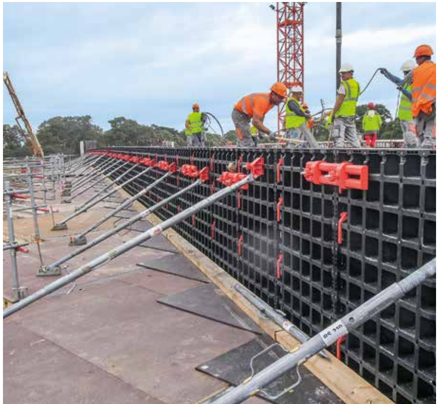
DUO ist mit kleinen Paneelgrößen und einfachem Handling prädestiniert zum Schalen von Fundamenten.
