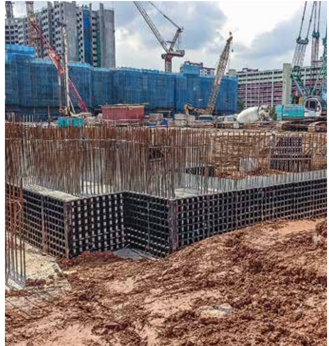
Die DUO Paneele eigneten sich bestens für das Schalen von kleinformatigen Betonbauteilen mit geringen Oberflächenanforderungen.
