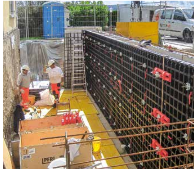
Umbau und Anbau ohne Kraneinsatz – bestens gelöst mit DUO.
