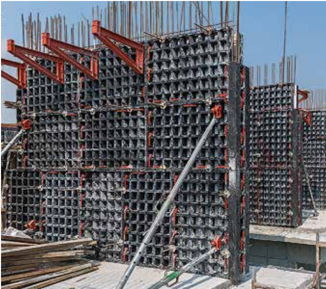
Erfolgreicher Ersteinbau der leichten Universalschalung für die Herstellung von Wandscheiben.
