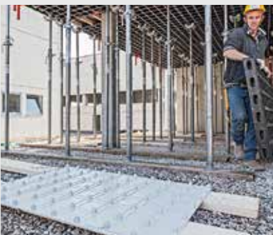
3. Bereitlegen der neuen Schalhaut
