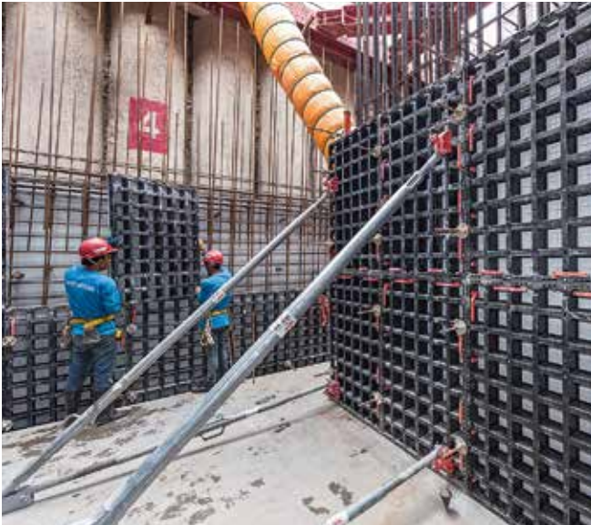
Geringes Gewicht, kleinformatische Schalungselemente – diese Vorteile spielt DUO bei diesen Tiefgeschosswänden voll aus.
