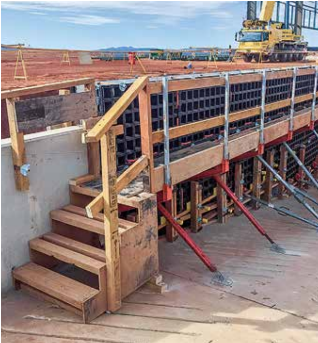
Der Einsatz der DUO ermöglichte eine erhebliche Effizienzsteigerung auf der Baustelle.
