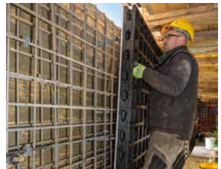
Die leichten DUO Schalungselemente waren ideal für das Bauen im Bestand geeignet.
