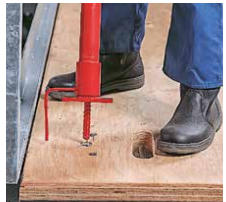
Der Stirnpfosten FBP zur Aufnahme der bauseitigen Geländerbohlen wird in die Mehrzweckbefestigung (DW 15) eingedreht.
