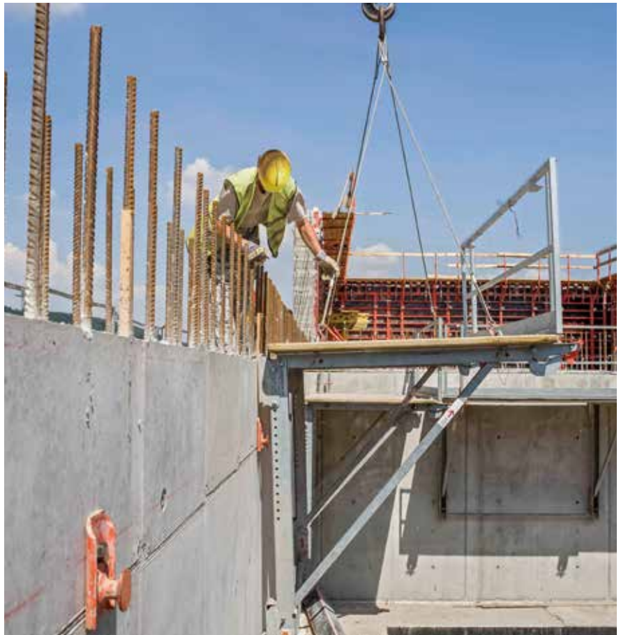
Die vor Ort montierte Faltbühne können Sie mit einem Vierstranggehänge schnell in Position heben.
