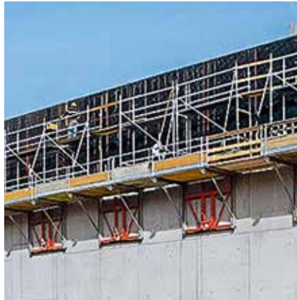
Die Falteckbühne im Einsatz an einer geraden Wand mit aufstehendem Bewehrungsgerüst PERI UP.
