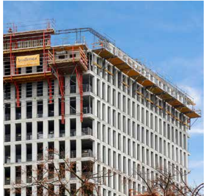
Die Montage der Faltbühne FB 180 vor Ort gestaltete sich als unkompliziert und schnell, da sie bereits vormontiert auf die Baustelle geliefert wurde.
