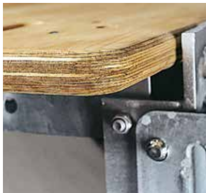
45 mm starker Bühnenbelag aus mehrfach verleimten Schichtholzplatten.
