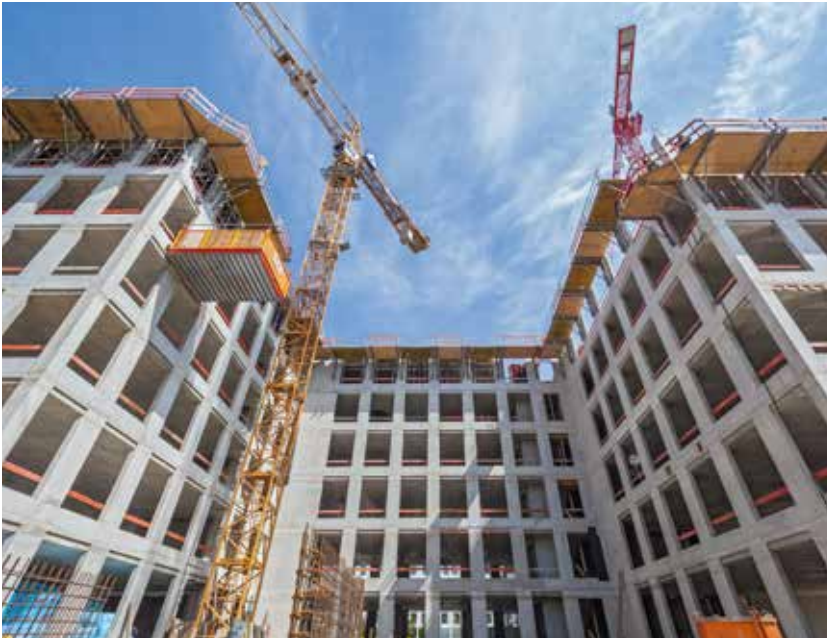
Für das Büro- und Hotelgebäude diente das Faltbühnensystem FB 180 als Arbeits- und Schalungsgerüst. Zum Umsetzen und Zwischenlagern von Schalungsmaterial war eine RCS MP Ausfahrbühne variabel platzierbar.
