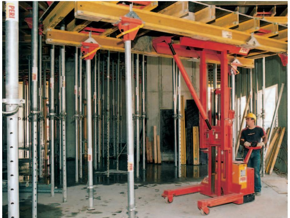
Die Bauhöhe von 1,6 m erlaubt den Einsatz auch in Tiefgaragen. Einsatzhöhen bis 5 m sind möglich.
