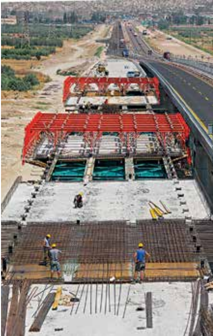
Mithilfe der beiden Schalwagen und zweier zusätzlicher, vorlaufender Bodenschalungen konnten die bis zu 22,50 m langen Feld- und Stütztafte im Pilgerschrittverfahren hergestellt werden.
