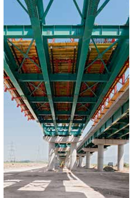
Die beiden parallel verlaufenden Überbauten der 22-feldrigen Brücke wurden in Stahlverbundbauweise hergestellt.
