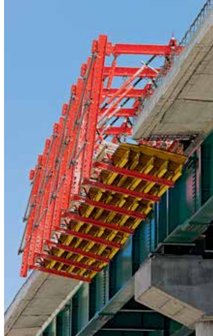
Mit der Diagonalspindel ließen sich alle Neigungen und Höhenlagen der Kragarmschalung justieren.
