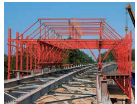
Der Ausschalvorgang erfolgt wahlweise von der Betonebene oder der Nachlaufbühne.
