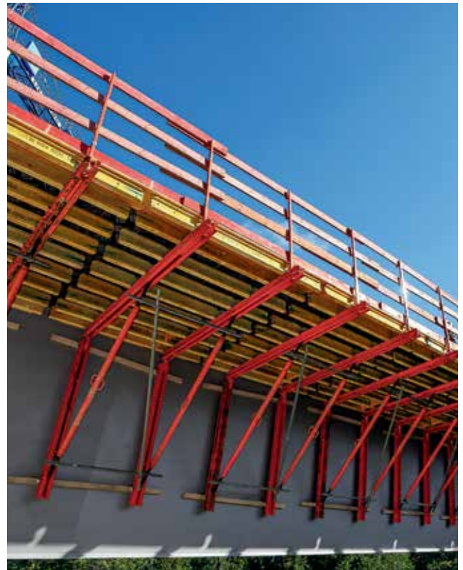
Renkertobelbrücke, Riedbergpass, Deutschland
