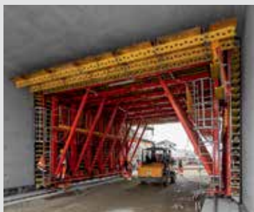
Offene, teilmonolithische Bauweise
