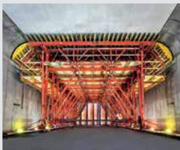
Offene, aufgelöste Bauweise
