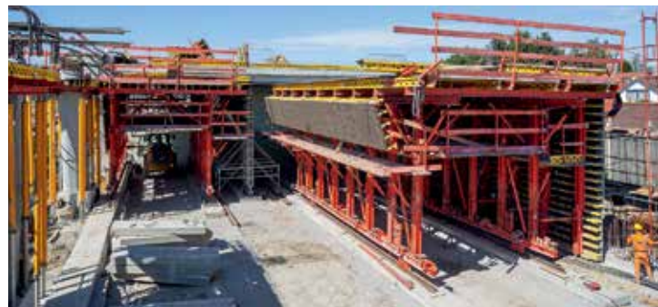
Smarte Engineeringlösungen mit Klappmechanismus ermöglichen eine PERI UP Nachunterstützung und damit frühzeitiges Verfahren des Schalwagens.
