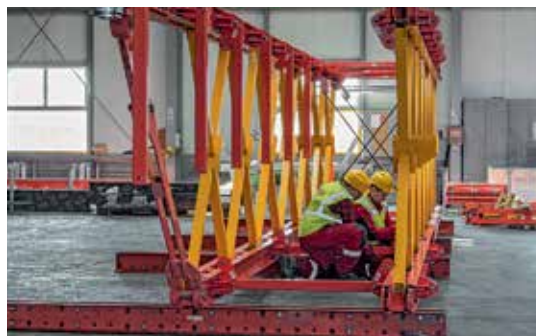
Um Montagezeiten vor Ort zu minimieren und enge Bauzeitvorgaben einhalten zu können, liefert PERI bei Bedarf auch vormontierte Einheiten auf die Baustelle. Mietbarkeit und Montagevorteile machen VARIOKIT insbesondere bei kurzen Laufzeiten ausgesprochen wirtschaftlich.
