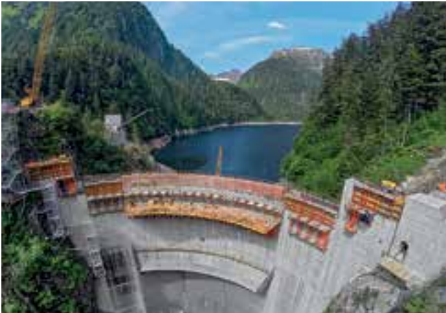
Ein Staudamm wurde aufgestockt: Im Rahmen der Erweiterung eines Wasserkraftwerks war diese Staumauer in Alaska zu erhöhen.
