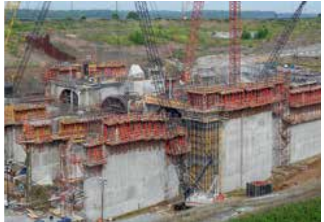
Die massiven Kraftwerkswände wurden mit dem Klettersystem SCS einhäufigt geschalt und betoniert.
