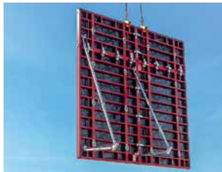
... Versetzen der vormontierten Wandschalungseinheiten inklusive Richtstützen mit dem Kran ...
