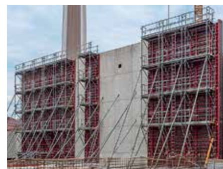
Einsatz mit MAXIMO Schalung und MXP Kundenzentrum, Winnenden, Deutschland
