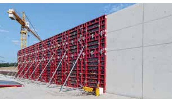
Einsatz mit MAXIMO Rahmenschalung Produktionshalle und Verwaltungsgebäude CIMC Silvergreen, Günzburg, Deutschland
