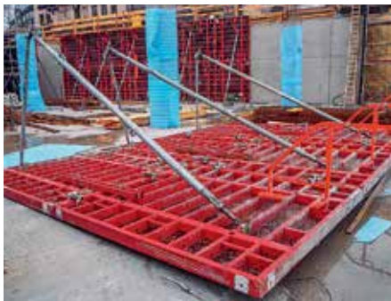
Einfache und sichere Montage von Richtstützen und Auslegern an der liegenden Schalung, ...
