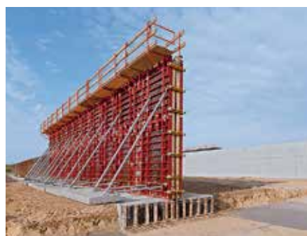
Einsatz mit TRIO Rahmenschalung Biomasselager, Zuckerfabrik Anklam, Deutschland
