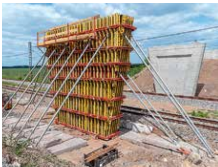
Einsatz mit VARIO GT 24 Trägerwandschalung Brückenpfeiler, Velim Eisenbahnstreckung des Forschungsinstituts VUZ, Tschechien
