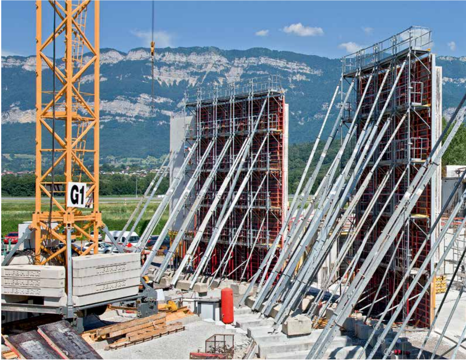
Einsatz mit VARIO GT 24 Trägerwandschalung Brückenpfeiler, Velim Eisenbahnstreckung des Forschungsinstituts VUZ, Tschechien
