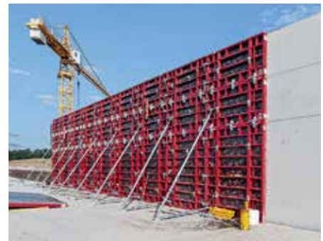
... und Einbau an der erforderlichen Stelle.
