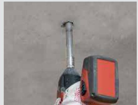
Schritt 3 Eindrehen des Sanierungsankers mittels Schlagschrauber
