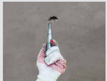
Nach Demontage der Konsole Ausbau des wiederverwendbaren Anschlusselements
