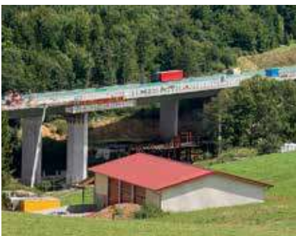
Während der Brückenbauarbeiten wurde der Verkehr auf der Autobahn A 81 im Baustellenbereich zwischen den Anschlussstellen Geisingen und Engen auf dem bereits fertiggestellten Überbau geführt.
