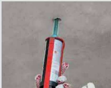
Schritt 2 Injizieren des Verbundmörtels
