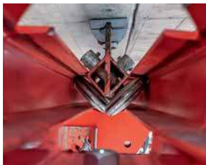
Die VARIOKIT Gesimskappenbahn war über Fahr-schienen und Rolleneinheiten an der Unterseite des Brückenkragarms angehängt – bei identischer Position zum Verfahren und Betonieren.
