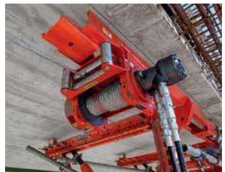
Mittels integrierter Seilwinde ließen sich die Einheiten schnell umsetzen.
