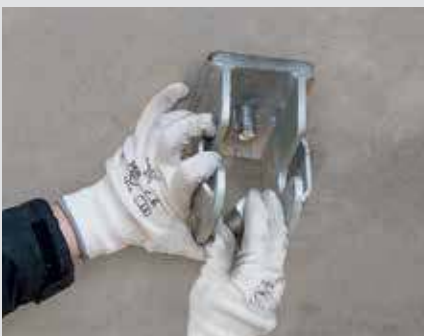
Schritt 4 Befestigung des Aufhängekopfs VGK mit der Mutter M24
