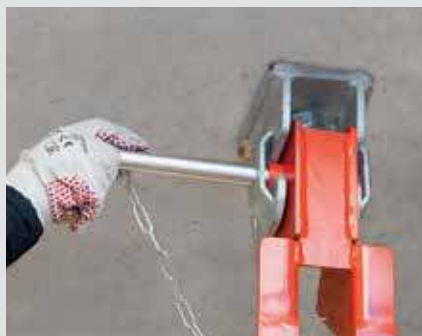
Schritt 5 Befestigung der VGK mit Bolzen
