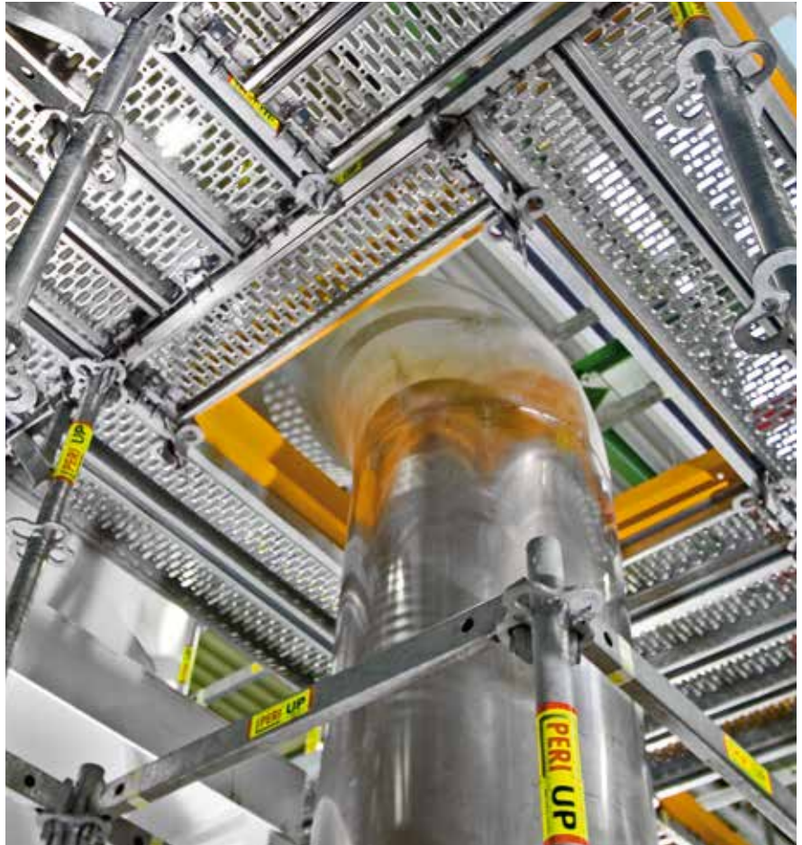
Der Richtungswechsel von Belägen im 25-cm-Raster bietet eine enorme Anpassungsfähigkeit – und das ganz ohne Rohrkupplungen.
