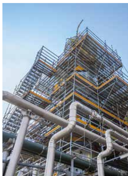
Gleichläufige Gerüsttreppen haben den Vorteil, dass neben den Treppenläufen auch Arbeitsebenen verfügbar sind.
