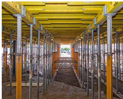
Bei Anwendungen mit GT 24 werden weniger Träger, Stahlgurtungen oder Deckenstützen benötigt. Das bringt Material- und Lohnkosteneinsparungen mit sich.
