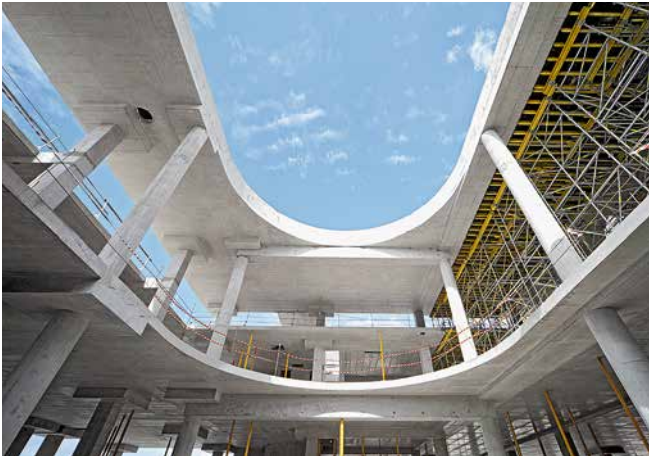
Die 30 cm starken Stahlbetondecken wurden mit MULTIFLEX geschalt.
