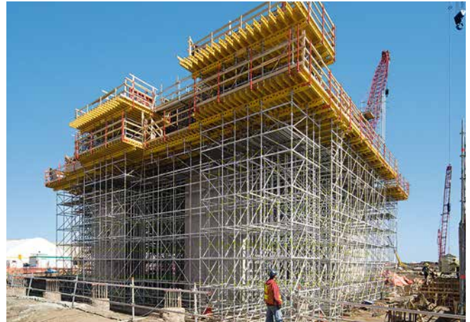
Mit PERI UP Rosett und MULTIFLEX ließen sich die hohen Lasten der massiven Bauteile in Höhen zwischen 10 und 12 m zuverlässig in den Untergrund ableiten.
