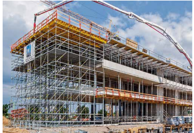
Komplettlösung aus einer Hand: Wand- und Deckenschalungen sowie Trag- und Bewehrungsgerüste waren optimal auf die Projektanforderungen abgestimmt.
