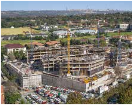
200.000 m 2 Geschossdecke in Form gebracht
