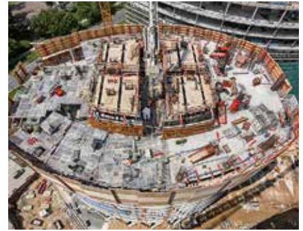
Elliptische Deckenfläche mit Standardbauteilen
