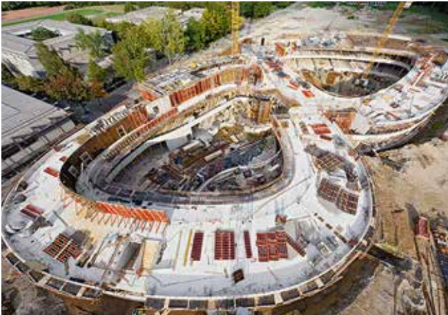
Schulmäßige Ausführung: Die Ortbetonrundungen haben veränderliche Radien.
