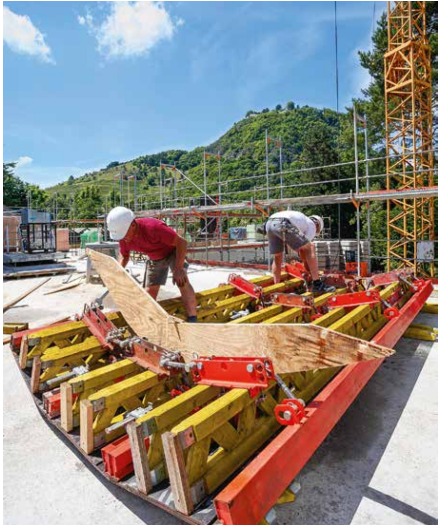
Die Kontrolle der vorgegebenen Krümmung erfolgt durch Aufsetzen der Radiusschablone auf die Schalungsträger.
