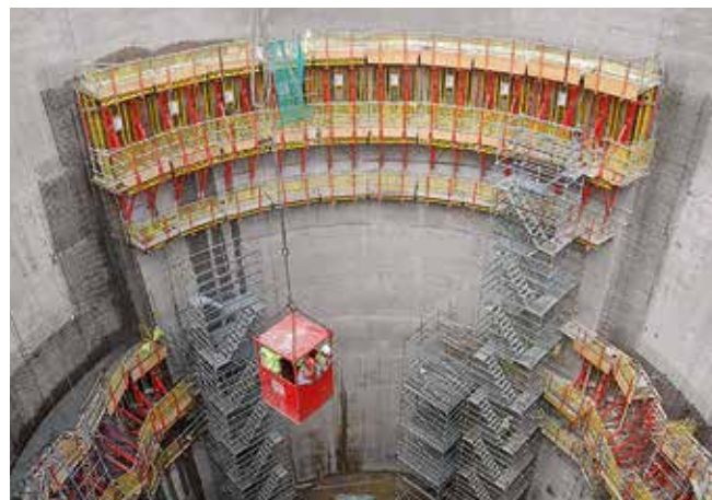
RUND FLEX im Einsatz für den Schacht einer Pumpstation mit einem Durchmesser von 25 m.
