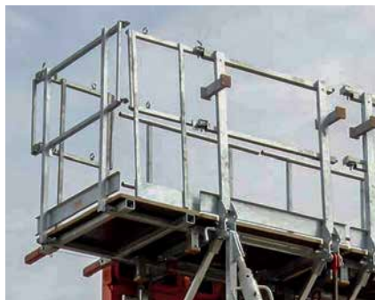
Das Stirngeländer einer Bühne ist bis zu 180 ° schwenkbar. So lässt sich beispielsweise auch eine um 90° versetzt angeordnete Bühne mit Geländer absichern.
