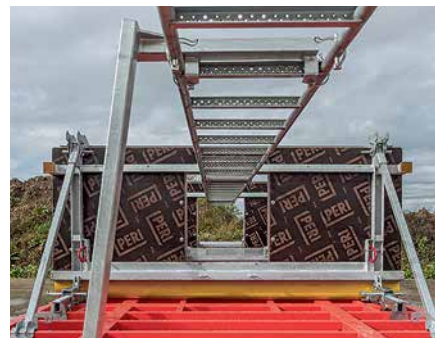
Die Leitern und breite Durchstiegsluken sorgen für bequeme Verkehrswege, um schnell und komfortabel von Bühne zu Bühne wechseln.
