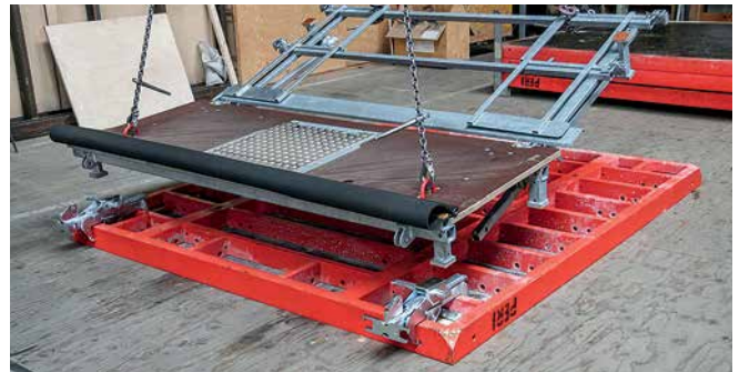
2. MXP Bühne mittels Krangelänge auf Element positionieren.
